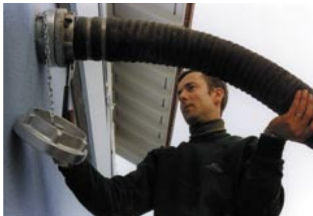
Fornitura di pellets con autocisterna.
